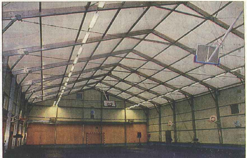
Le coût de ce gymnase s'élève à 530 000€ dont 460 000€ pris en charge par le Département.
