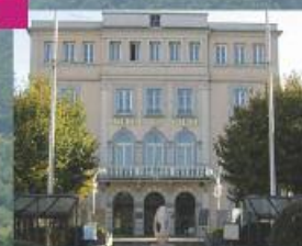
Pont de Claix
