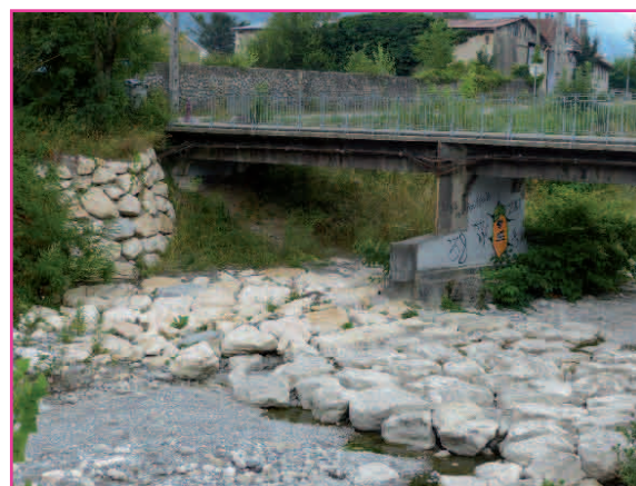
Sigreda : Travaux sur la Gresse : 96 441 €
