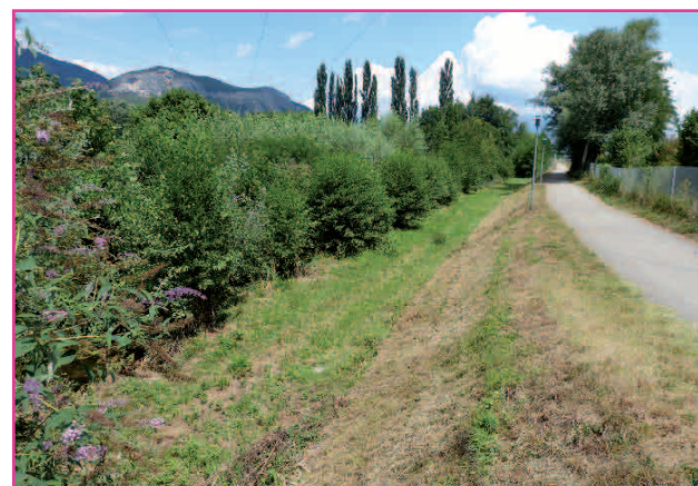
Syndicat du Lavanchon : confortement des berges le long de la piste cyclable : 11 520 €
