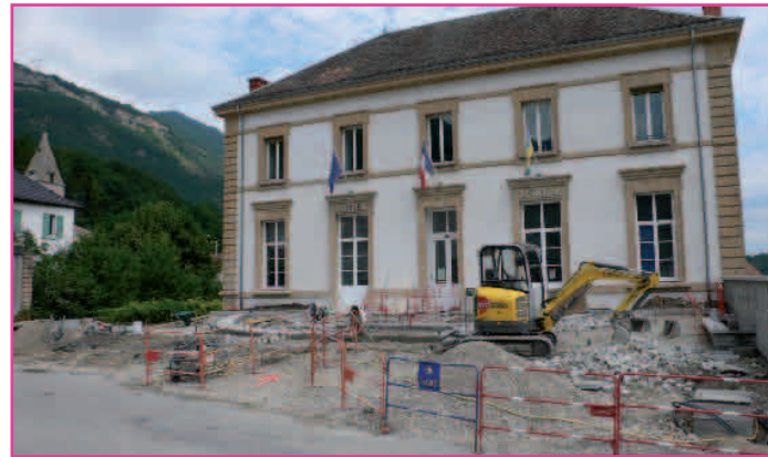
Le Gua : réhabilitation de la mairie : 59 902 €
